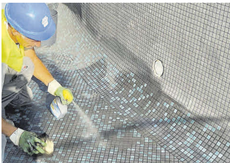
'Epoxy Pro' limpia los residuos epoxídicos en la fase de rejuntado sin necesidad de volver a la obra.
