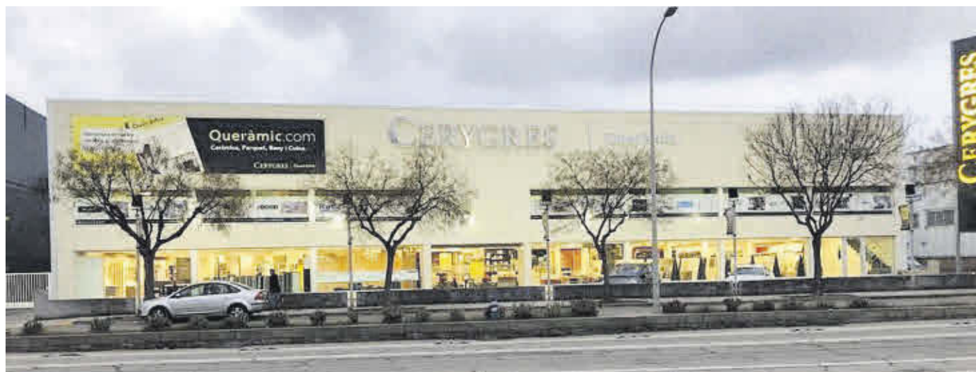
Vista de la fachada de las instalaciones centrales de Cerygres, ubicadas en el polígono industrial El Pla de Molins de Rei, en la provincia de Barcelona.
