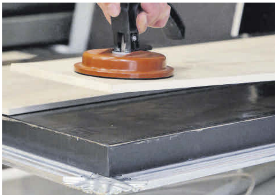
Las baldosas que integran el sistema pueden retirarse fácilmente sin dañar el soporte.
