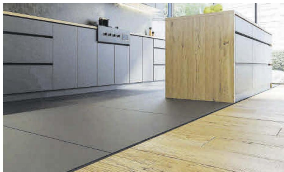
'Novoescuadra Mini, un perfil superpuesto, válido para todo tipo de revestimientos, incluso en paredes de yeso y papel pintado. A la derecha, 'Novosepara Mini', un separador de pequeñas dimensiones.
