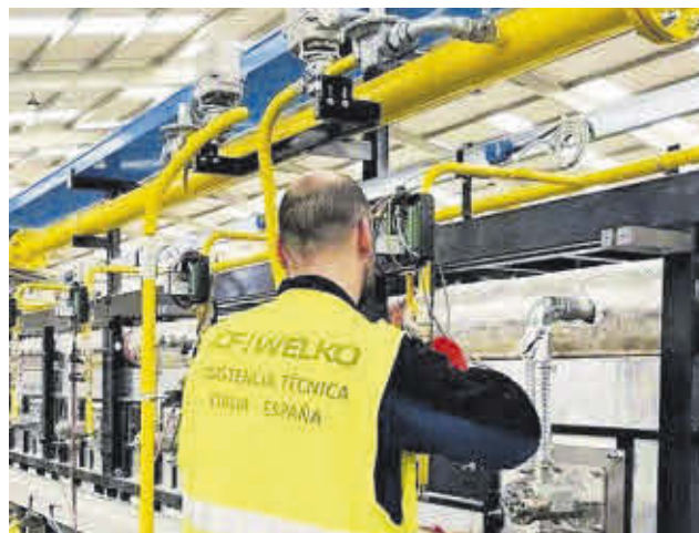
La planta ahorrará hasta un 30% de energía gracias a sistemas de recuperación de calor y al aislamiento térmico de alta densidad.
