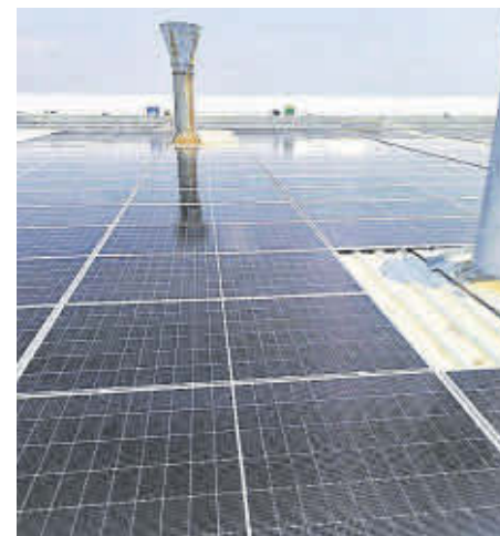
La instalación, con una potencia de 726 kWp, espera generar una producción anual de 900 MWh.
