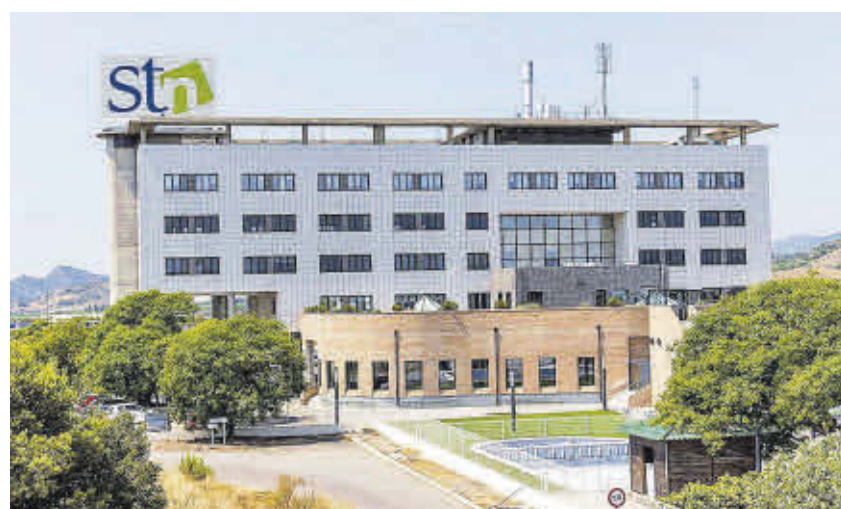
El edificio corporativo de Grupo STN donde concentra la actividad de oficinas.
