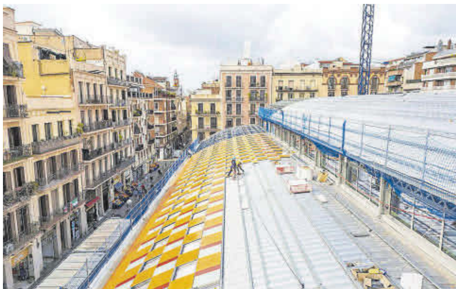
En la envolvente del edificio cobran especial protagonismo las piezas porcelánicas de Frontek, el sistema constructivo elegido para dotar al mercado de una cubierta singular y resistente.
