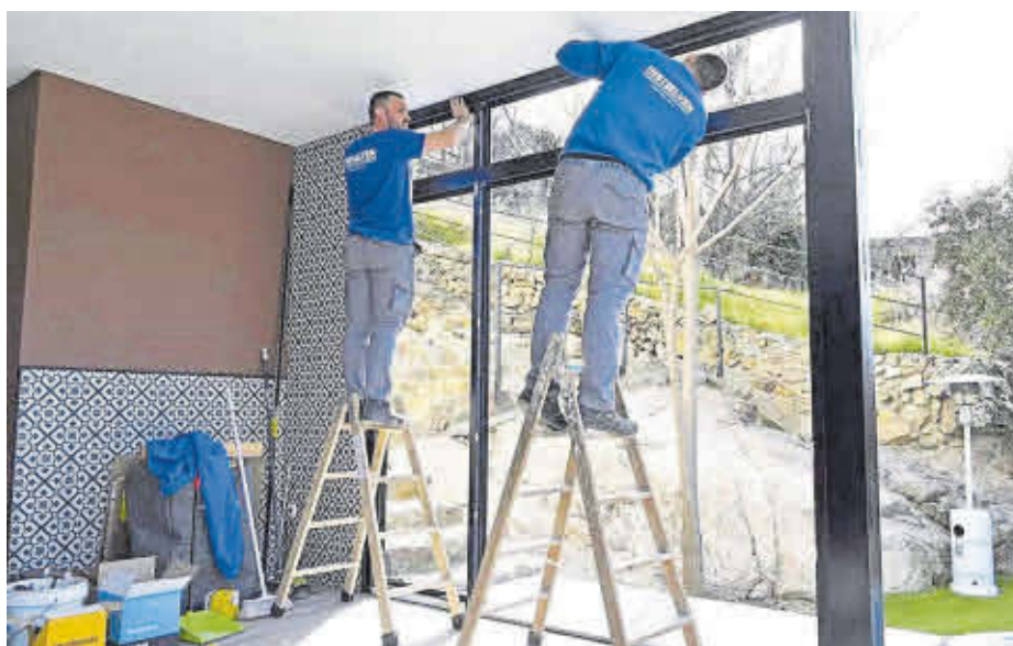
Dos profesionales durante la instalación de nuevas ventanas en la reforma de un chalet.
