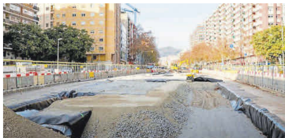
El calendario prevé la ejecución del pilotaje en vía pública a partir del próximo mes de octubre.
