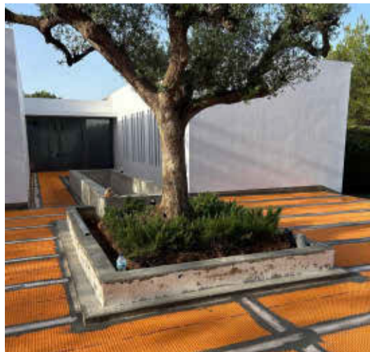
El sistema de impermeabilización y desolidarización 'Schlüter-Ditra' facilita la colocación de la lámina al soporte.
